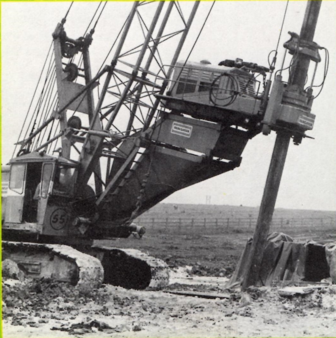
RT3-S con sistema di guida aste per pali inclinati fino a 15° e telaio intermedio per alzare la macchina di 1 m (FAIRCLOUGH - INGHILTERRA). RT3-S with Kelly guiding system for 15° raked piles and 1 m raised chassis. (FAIRCLOUGH - U.K.).
